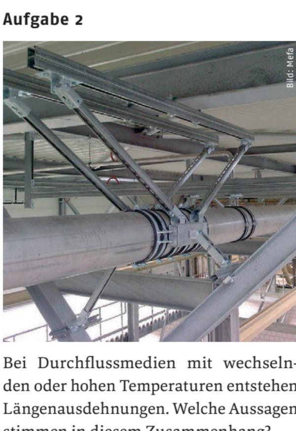
Bei Durchflussmedien mit wechselnden oder hohen Temperaturen entstehen Längenausdehnungen. Welche Aussagen stimmen in diesem Zusammenhang?
