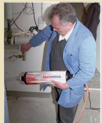
■ Bild 3: Befüllen der Heizungsanlage.
