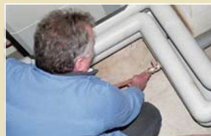
■ Bild 2: Verbindung der Patrone mit dem Heizungs-Füllanschluss.
