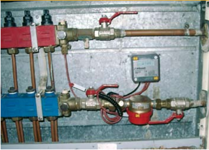
■ Bild 7: Falsche Einbaulage: In dem einen Fall befindet sich das Volumenmessteil auf dem Kopf, in dem anderen Fall ist der Wärmemengenzähler schräg eingebaut.
