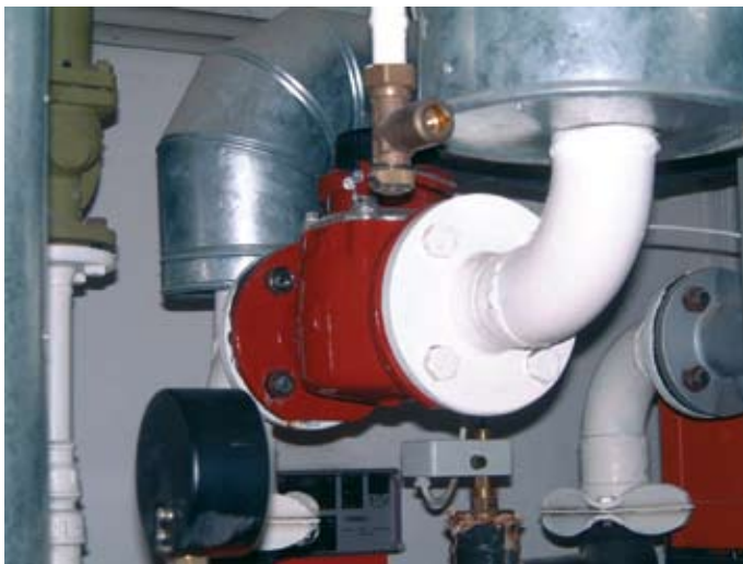
■ Bild 4: Direkt an den Wärmemengenzähler angeflanshtes Formstück - keine Beruhigungsstrecke vorhanden.
