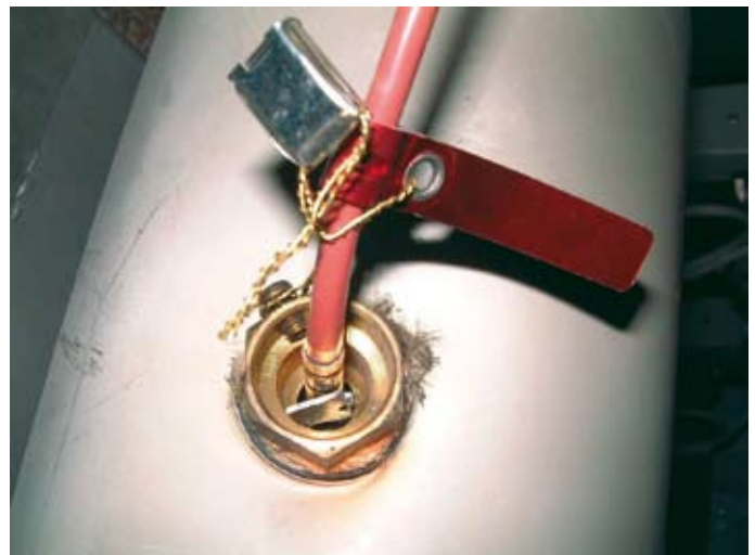
■ Bild 6: Diese Tauchhülse ist für ein Thermometer vorgesehen, nicht für den Temperaturfühler eines Wärmemengenzählers. Durch den Luftspalt kommt es zu einer fehlerhaften Messung.
