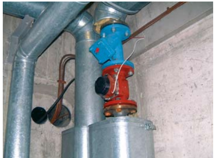
■ Bild 5: Direkt an den Wärmemengenzähler angeflanschter Schmutzfänger - ebenfalls keine Beruhigungsstrecke vorhanden.
