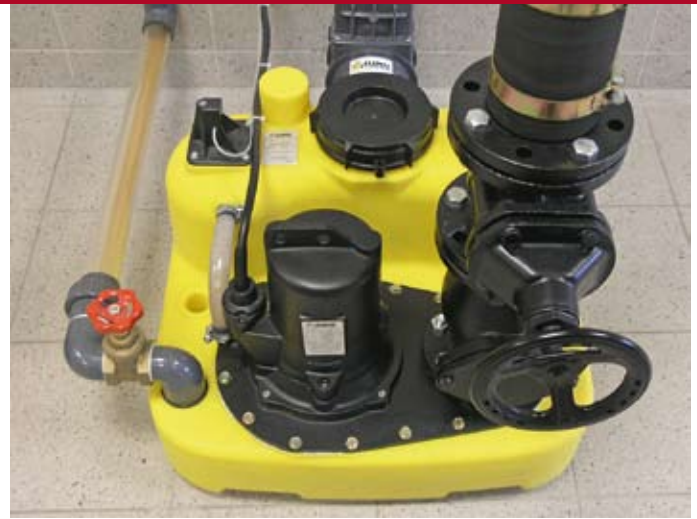
Bild 2: Fäkalienhebeanlage.
