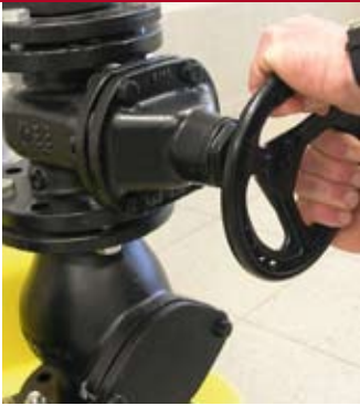
■ Bild 4: Überprüfung der Schieber-Funktionalität.
