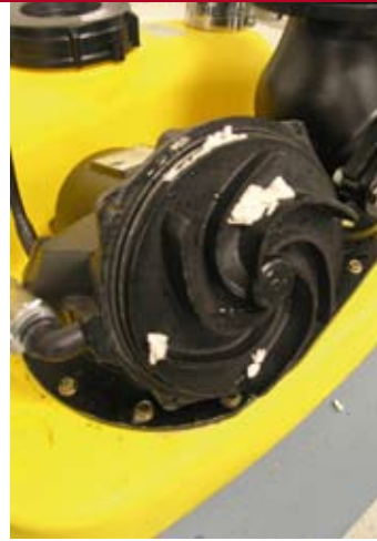
■ Bild 6: Überprüfung und Säuberung des Laufrades und des Schwimmers.
