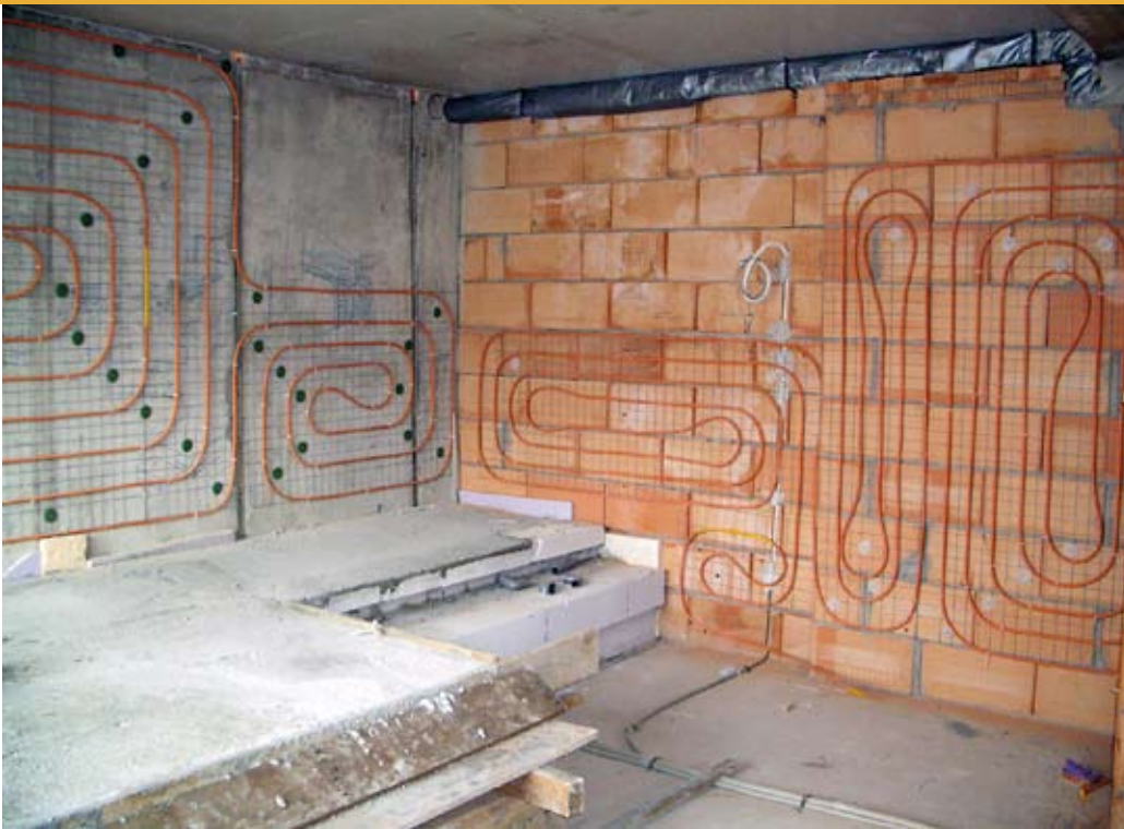
■ Flexibilität ist Trumpf: Unterschiedliche Verlegevarianten einer Wandheizung.
