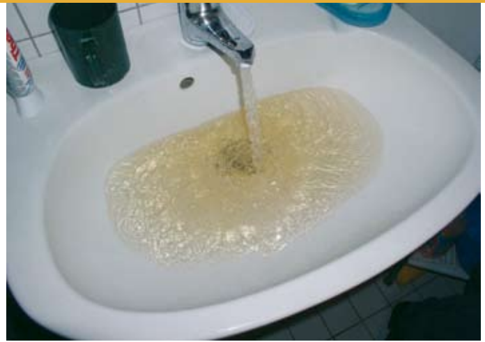
■ Mängel in Trinkwasseranlagen äußern sich im Wesentlichen durch Störungen der Transportfunktion oder Beeinträchtigungen der Trinkwasserqualität. In der überwiegenden Zahl der Fälle ist Korrosion ursächlich für die Schäden.
