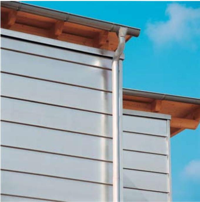
■ Den Übergang zwischen Dach und Fassade markieren Dachrinnen und Regenfallrohre der Fricke GmbH & Co. KG. Sie sind aus Kupfer gefertigt und in allen „Tecu“-Oberflächenfarben verfügbar. Dadurch harmonisieren sie mit der aus „Tecu-Zinn“ gefertigten Fassade, sodass ein stimmiger Gesamteindruck entsteht.
