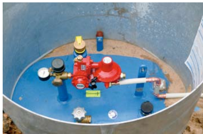
■ Platz sparend: der erdgedeckte Behälter mit Druckregler.
