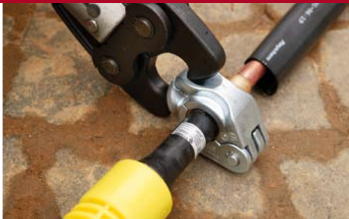
■ Mittels einer Geopress-Verbindung wird die Hauseinführung sicher mit der Versorgungsleitung verbunden.
