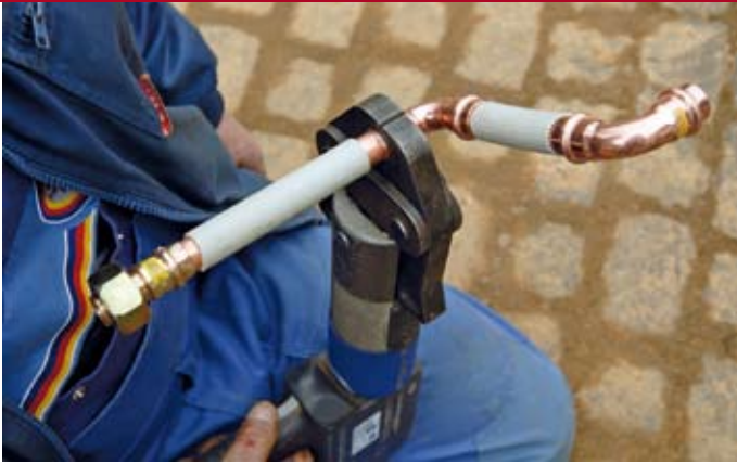
■ Der Tankanschluss kann auch mit zugelassenen Press-Systemen montiert werden.
