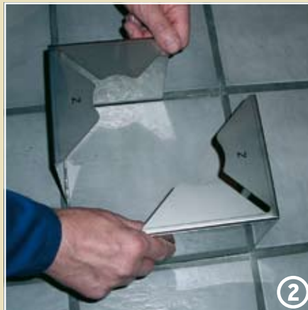
■ Die Edelstahlblechen werden in die Fugenschlitze eingesetzt.
