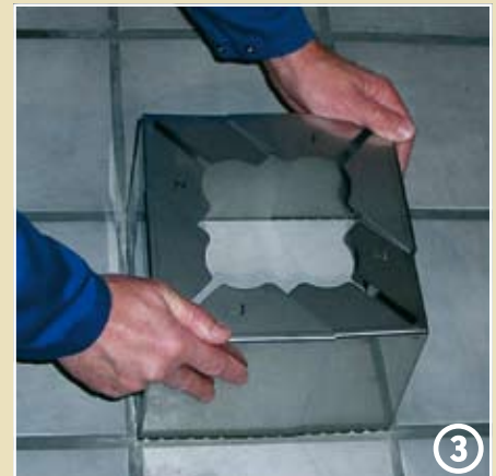
■ Die einzelnen Elemente bilden zusammen eine Haube. Anschließend kann diese mit einer Abdeckplatte verschraubt werden.
