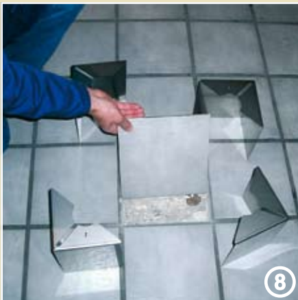
■ Nach der benötigten Ablösezeit liegt die Fliese lose im Fliesenbett und kann dann entnommen werden.
