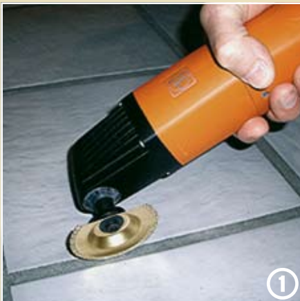
■ Im ersten Schritt werden die Fugen der betroffenen Fliesen entfernt.
