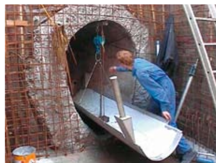
■ Bild 3: Wärmeübertragungselement mit Anschlussstützen beim Einbau in einen bestehenden Kanal.
