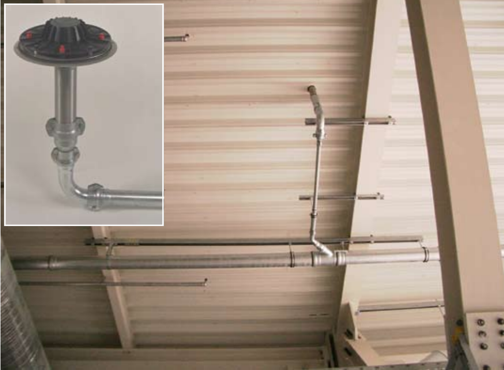
■ Druckentwässerung in Edelstahlausführung mit „JET-Flachdachablauf“.
