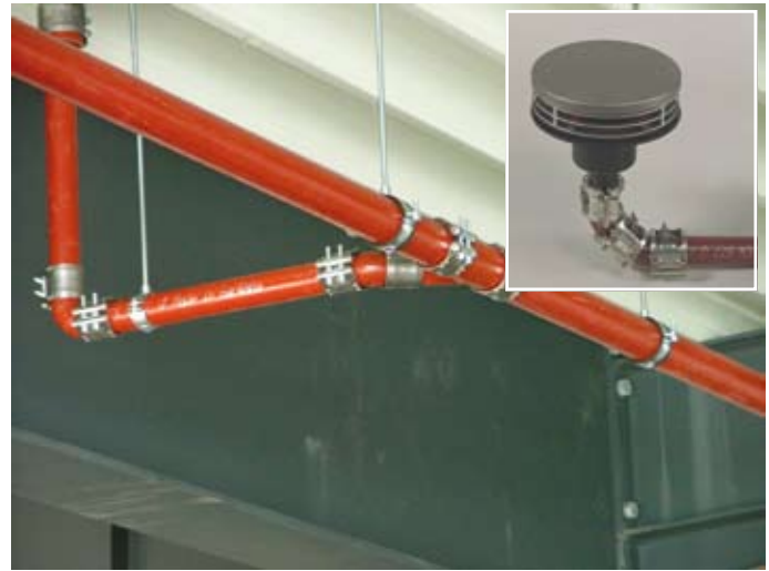
■ Druckentwässerung in Gusseisenausführung mit „JET-Flachdachablauf“.
