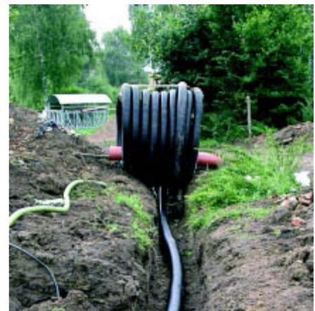
■ Praktisch: Verlegehilfe für das „pipe6“ Nah- und Fernwärmesystem mittels eines Traktors.
