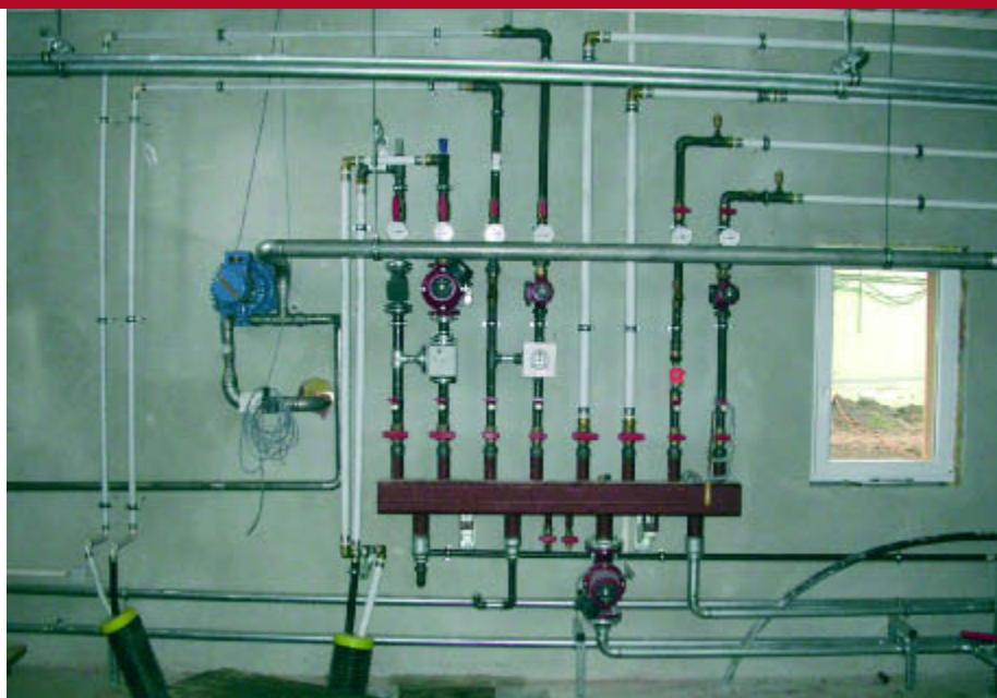
■ Wärmeverteilung für die Prozess- und Nahwärme.
