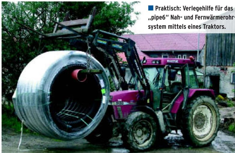
■ Das mit Flachs gedämmte Rohrsystem weist eine hohe Elastizität auf, was die Flexibilität des gesamten Rohrsystems bei der Verlegung erhöht.
