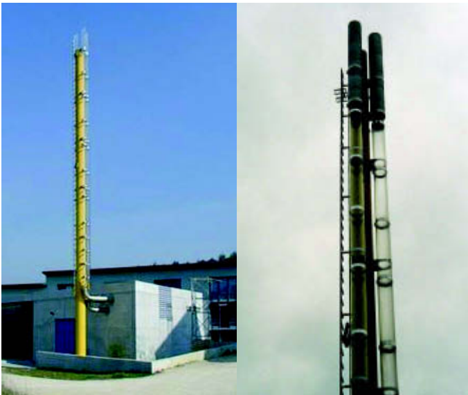
■ Bild 5: Abgasleitungen eines Blockheizkraftwerkes (links) mit Reinigbaren Rohr-Schalldämpfern (rechts, jeweils 3 Kammern) an den Mündungen als Nachrüstung.
