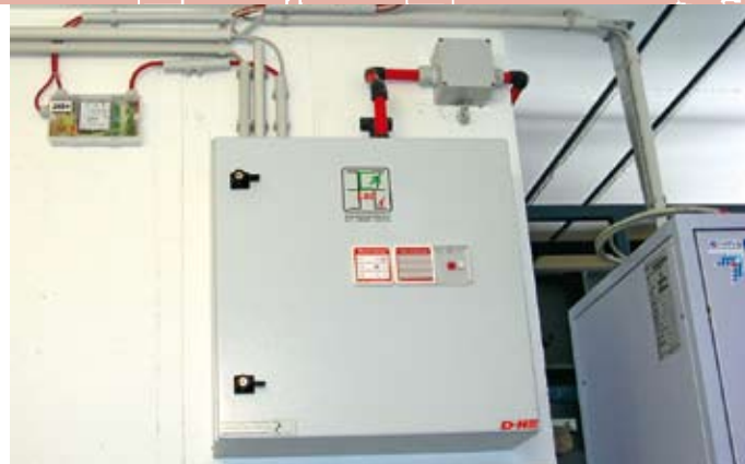
■ Die RWA-Zentrale - Meldet das System Rauchgas, werden die Entrauchungsklappen automatisch geöffnet. Das Komplettsystem wird betriebsfertig im Schaltschrank vormontiert und werkseitig geprüft geliefert.
