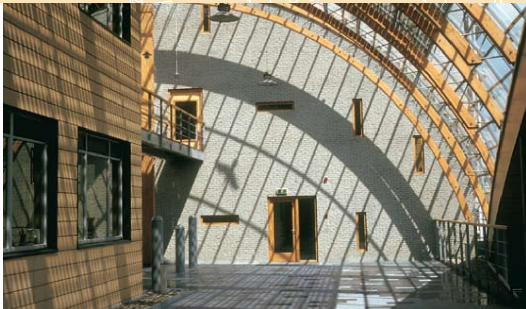
■ Bild 3: Der Flur auf der Frontseite der niederländischen Energy Research Foundation (ECN) wirkt wie ein Sonnenschirm. Er verschattet die dahinter liegenden Büros und sorgt für natürliche Lüftung.
