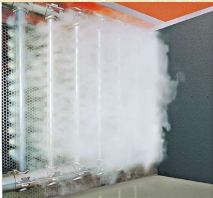
■ Mehrfach-Dampfverteilsysteme wie das „Condair OptiSorp“ von Walter Meier verteilen den Dampf gleichmäßig über den gesamten Luftstrom und erzielen dadurch sehr kurze Befeuchtungsstrecken.
