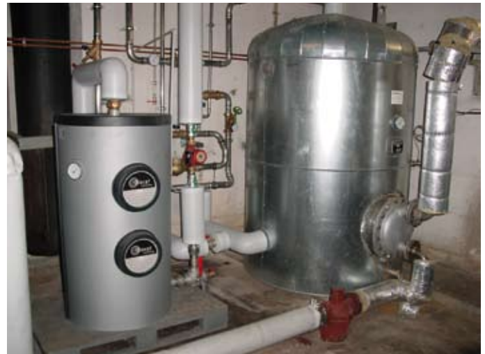
■ Bild 3: Kalkschutz ohne Chemie. Im Gegensatz zu Trinkwasseranlagen, bei denen die „Biocat KS“-Geräte in die Kaltwasser-Verteilung eingesetzt werden, kann bei Großwasserverbrauchern auch gezielt nur das Warmwasser geschützt werden. Dazu wird die „Biocat“-Anlage wie im Bild zu sehen in eine Umwälzleitung zum Warmwasserspeicher eingebaut.
