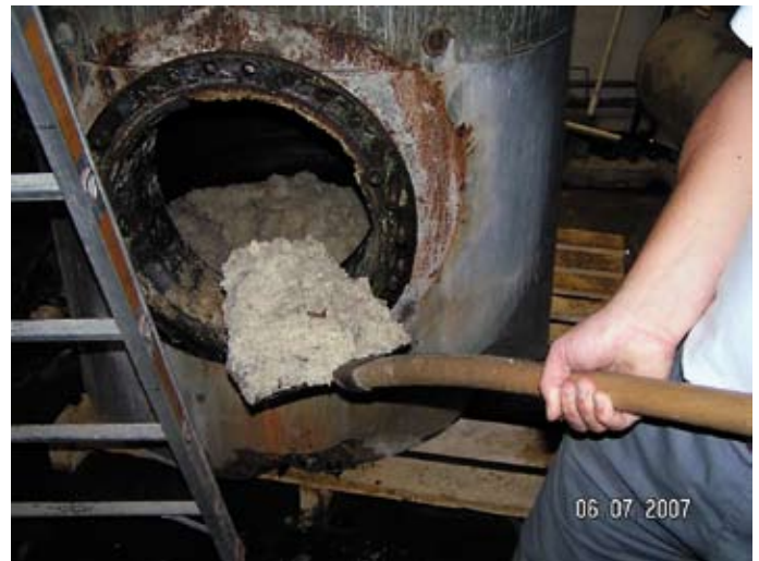
■ Bild 2: Mit einer Schaufel konnten rund 40 bis 50 kg Kalk aus dem Warmwasserspeicher entfernt werden.
