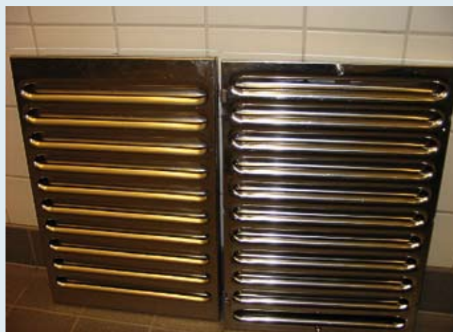
Verschmutzter und gereinigter Aerosolabscheider.
