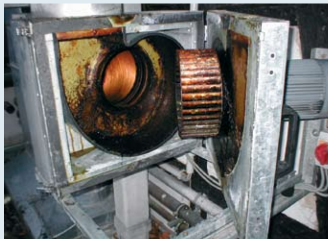
Aerosolatverschmutzter Abluftventilator.
