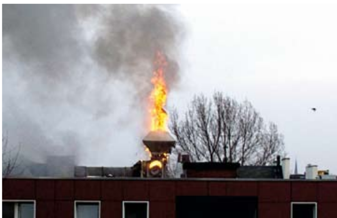
■ Bild 1: Brand in einer gewerblichen Küche aufgrund von Ausführungsmängeln.
