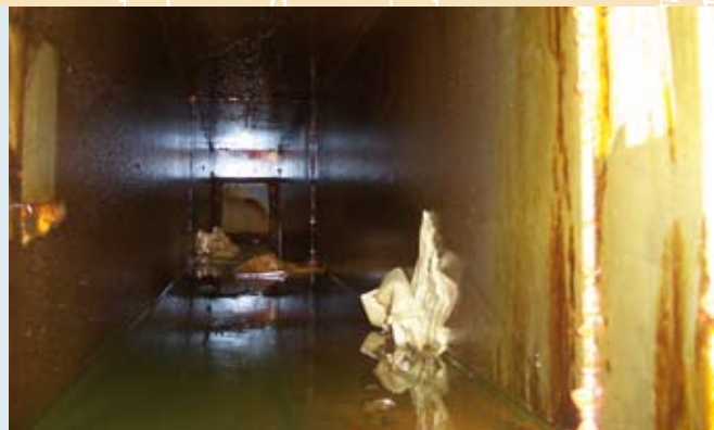
Aerosolatverschmutzte Luftleitung.
