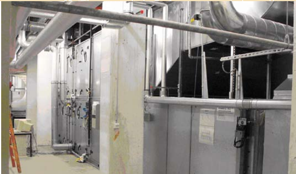
■ Bild 1: Beengte Platzverhältnisse in Technik-Zentralen zwingen oftmals zu Lösungen, die hinsichtlich Schallschutz- und Differenzdruck auch für die Schalldämpferbemessung nicht optimal sind.
