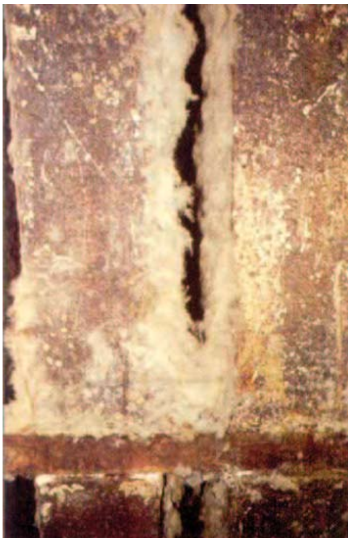
■ Bild 6: Starke Verschmutzungen - hier in einer PLT-Anlage [3] - treiben Druckverluste und Energiekosten unnötig in die Höhe.
