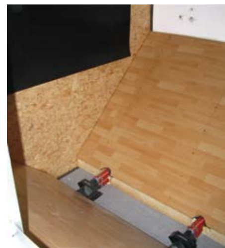
Schrägböden und Prallschutzmatte verhindern Beschädigungen des Lagerraums und die dadurch entstehende Verunreinigung der Pellets.
