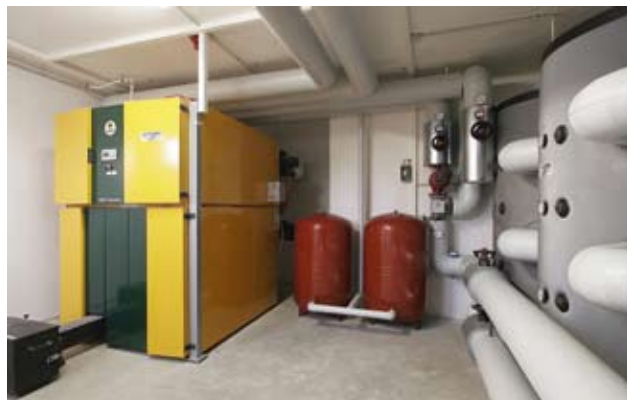
Auch in besonders anspruchsvollen Einsatzgebieten – wie hier in einem Hähnchenmaststall – liefern Pelletheizanlagen Wärme.
