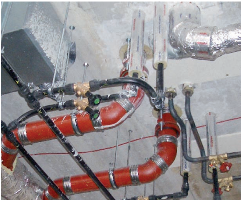
Deckendurchführung mit Conlit-Brandschutzschalen
