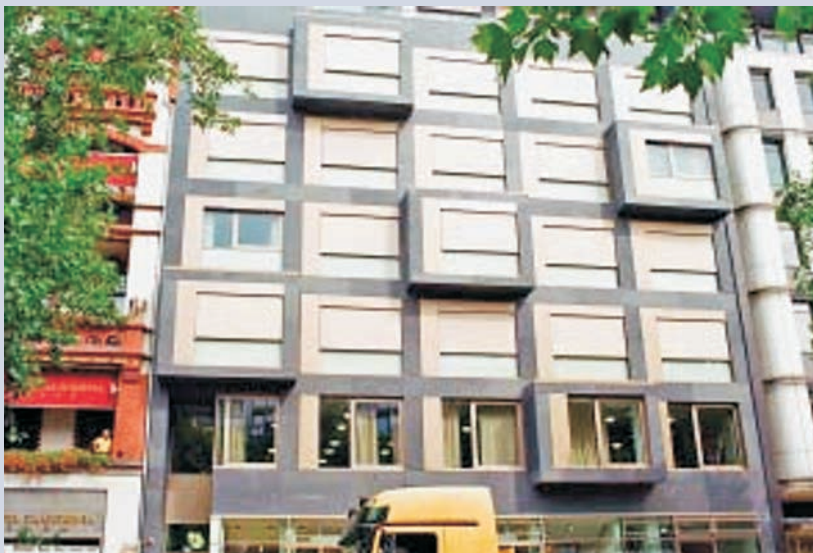
Neubau „California“-Erweiterung am Kurfürstendamm, Berlin
