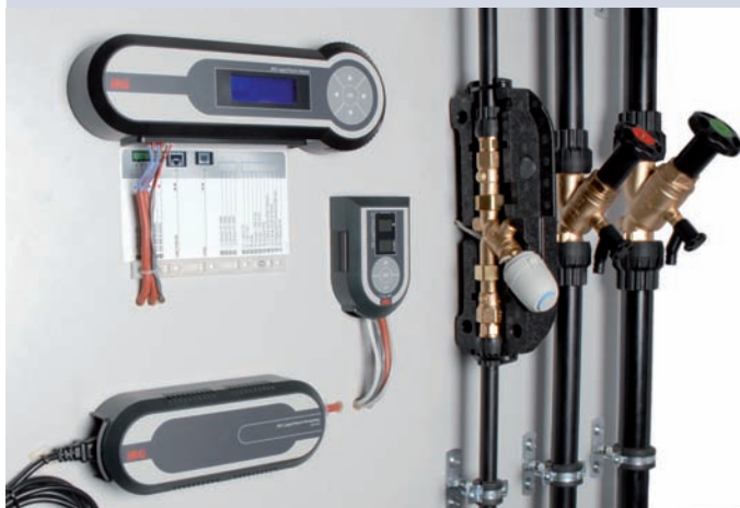
„LegioTherm“ mit dem zentralen programmierbaren „Master“ (oben), der Powerbox (Netzteil) zur Spannungsversorgung (unten)
