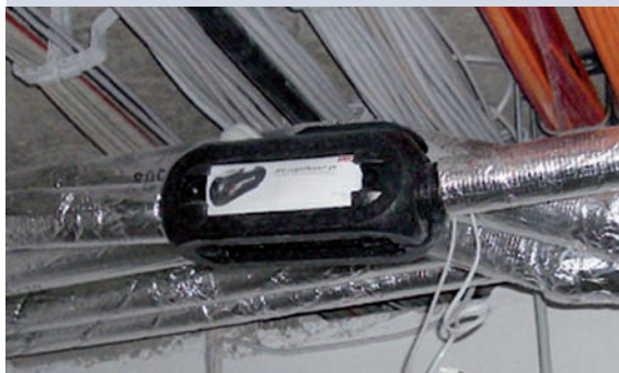
19 „LegioTherm“-Zirkulationsregler garantieren im Desinfektionsfall 70 °C auch im letzten Strang
