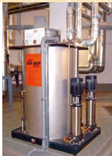
■ Bild 7: Drucklose Entgasungsbehälter nach dem „AIR-SEP“-Verfahren zur Druckhaltung, Entgasung und Nachspeisung können für Anlagen von 10 kW bis zu 9000 kW serienmäßig eingesetzt werden.
