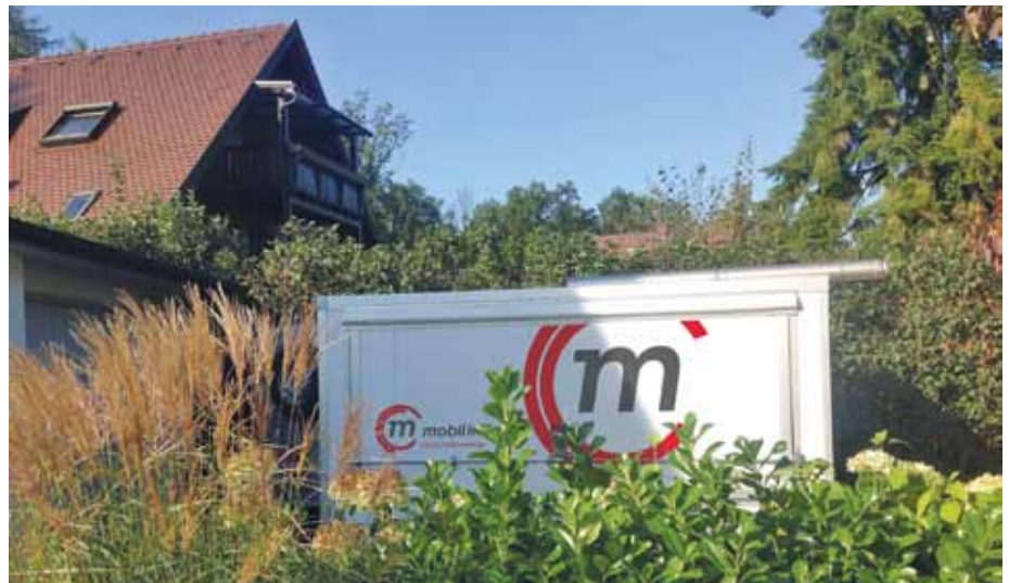
Nach einem Schwelbrand im Heizraum eines Einfamilienhauses in Wörthsee hatte eine vierköpfige Familie kein warmes Wasser mehr. Eine schnelle Lösung lieferte ein Heizmobil mit einer Leistung von 40 kW zur temporären Trinkwassererwärmung. Bild: Mobil in time
