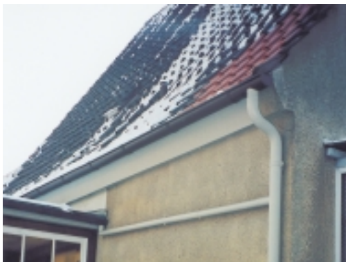
Absturzstelle vom Hausdach.
