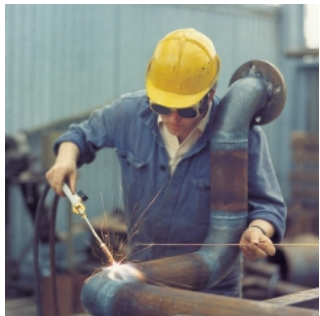
Bild 1: Im Rohrleitungsbau sollten keine „Feld-, Wald- und Wiesenstäbe“ verwendet werden, sondern nur hochwertige Zusatzstäbe (Foto: Messer Griesheim).
