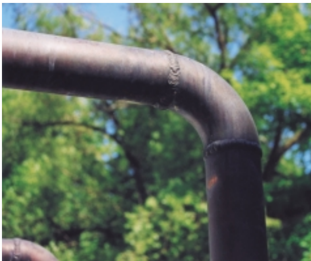
Bild 2: Praxisbeispiel: Druckluft-Kupferrohrleitung geschweißt. Aufgrund der hohen Korrosionsbeständigkeit des Werkstoffes ist ein Schutzanstrich nicht erforderlich.
