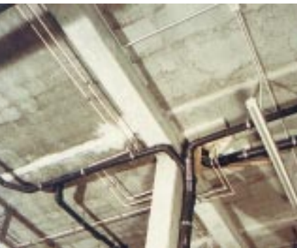
„Friaphon“, ein schalldämmendes Hauswasserabfluß-System.
