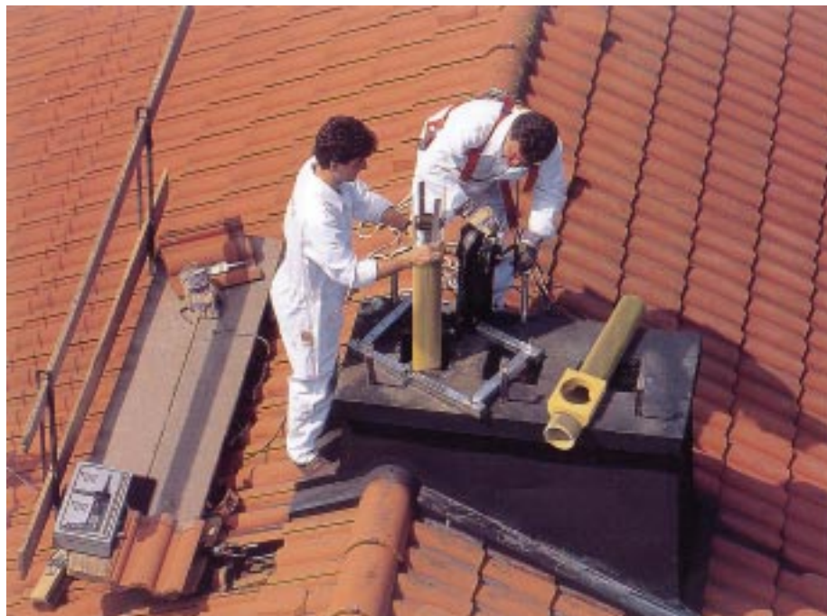
Bild 1: Die Schornsteinsanierung findet ohne Belästigung der Bewohner an der Schornsteinmündung statt.
