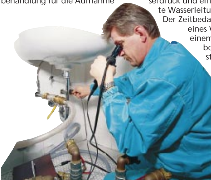
Einer der wichtigsten Schritte für den Installateur ist die Kontrolle kritischer Rohrstränge mit dem Endoskop.
